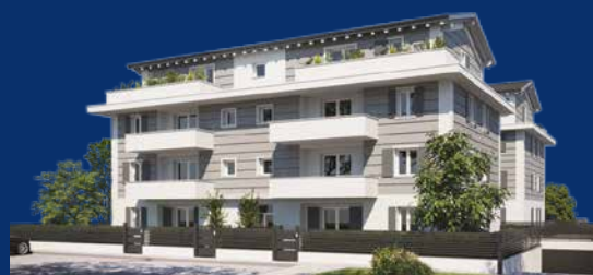
UBERSETTO - VIA MONTE AVE prossima realizzazione di n. 3 palazzine per complessivi 37 appartamenti
