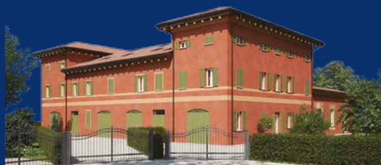
CASINALBO - VIA GIARDINI NORD, 232 restauro, adeguamento sismico ed energetico di palazzina di 4 appartamenti indipendenti immersi nel verde
